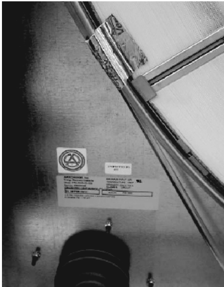
Figura 110. Instalación de banda de enlace
